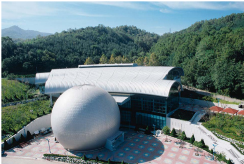
Bild 4: Highway Telekommunikationszentrum, Korea, Baujahr 2001; [Fa. Rheinzink GMBH Co KG]
