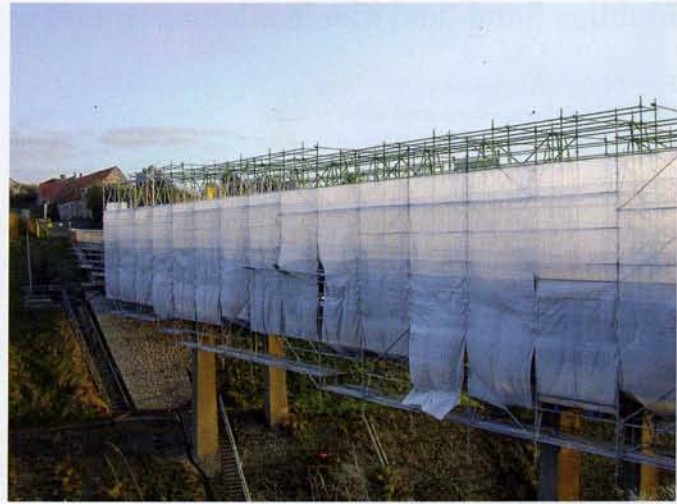
Bild 1. Stahlbetonbauwerke wie z. B. Brücken erfordern einen intakten Korrosionsschutz
