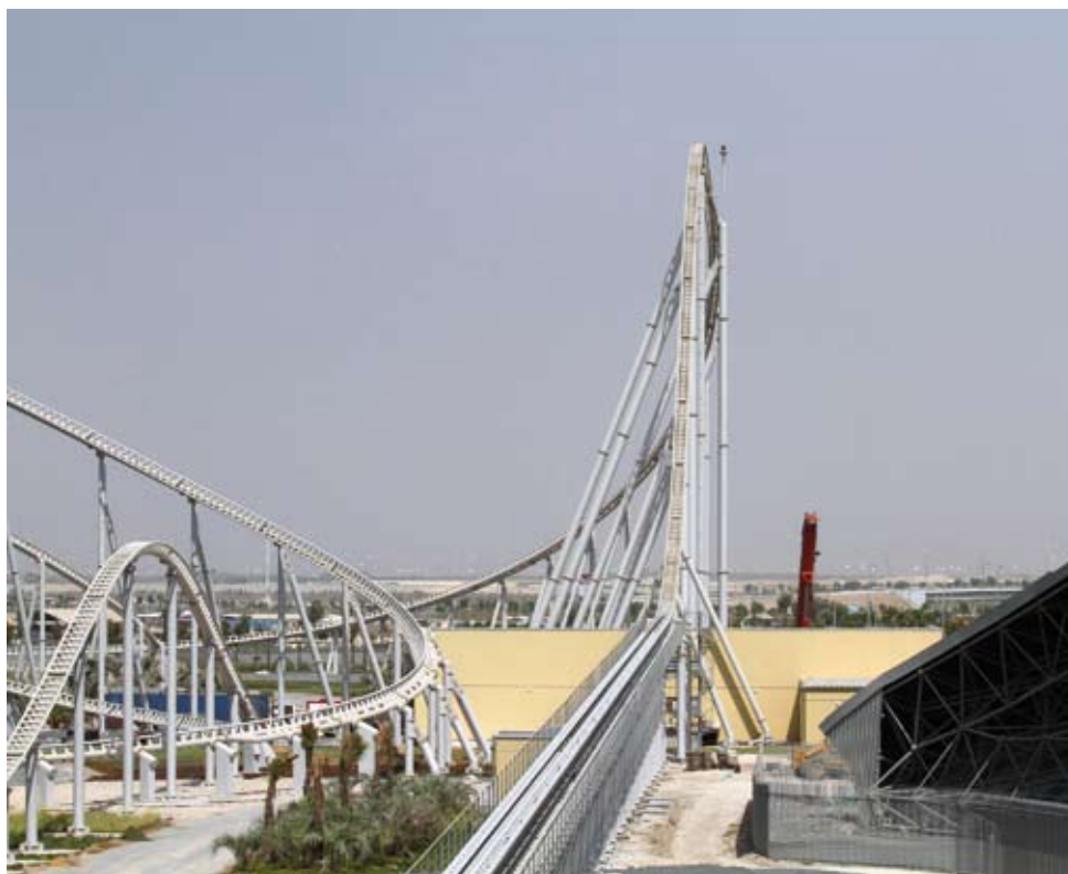
Die Sicherheitslaufroste für Wartung und Evakuierung sind längs der Fahrbahn montiert.
