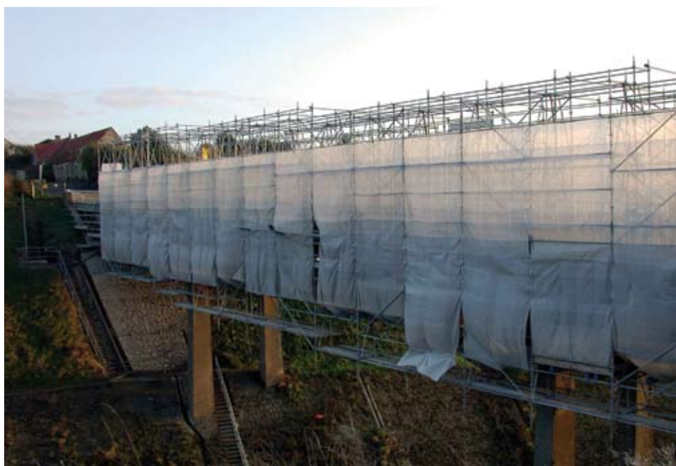
Brückensanierung durch Spritzverzinkung
