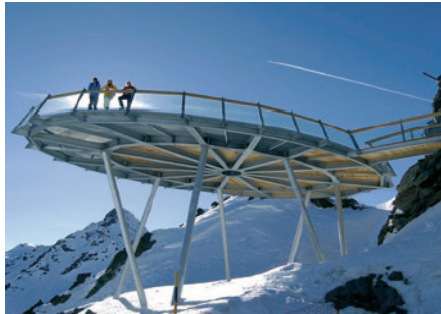
Feuerverzinkte Aussichtsplattform aus Stahl in 3.058 m Höhe in Sölden / Ötztal
