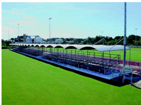
Abbildung 5: Feuerverzinkte Stahlkonstruktion, Tribüne des Stadions Gifhorn [Quelle: Institut Feuerverzinken]
